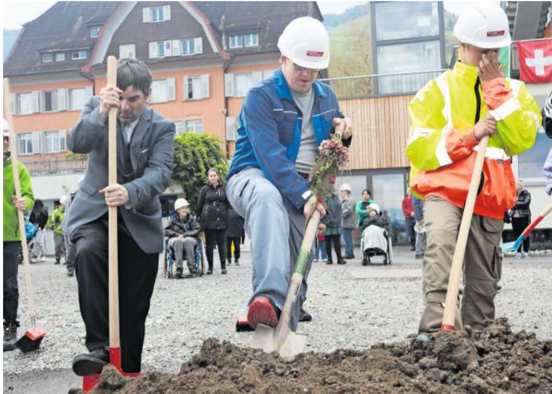
Die ersten Spatenstiche durften die Bewohnenden des Lukashauses setzen.
