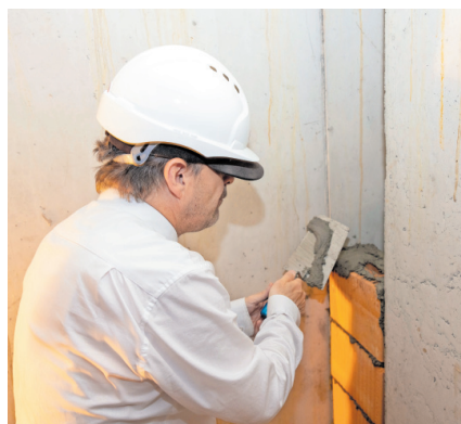
Die Bewohner durften die Zeitkapsel in die Wand einmauern.
