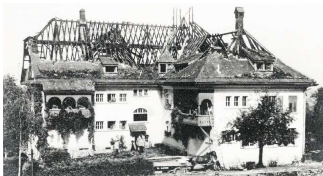
Am Tag danach bot sich ein trostloser Anblick: Der Dachstuhl war zerstört. Bilder: Archiv Hansruedi Rohrer
