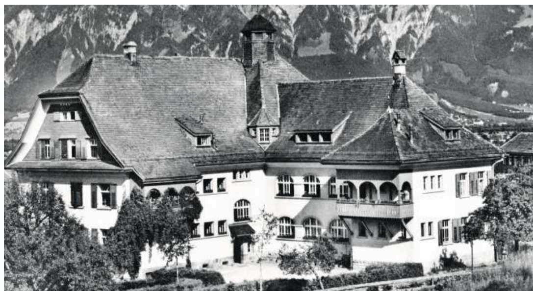
So sah das stolze Gebäude vor dem Brand aus.
